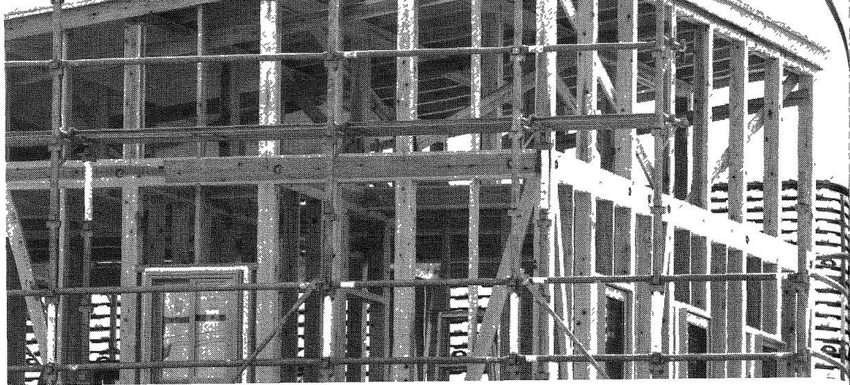
建築中の木造住宅
